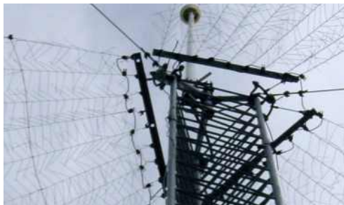
사다리형 어레이(Trapezoid Array) 산업용 또는 통신타워등에 적용되며 측방외에 방지에 효과적임.
