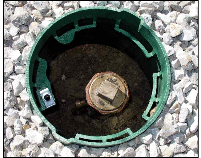
설치 후 접지 점검구
