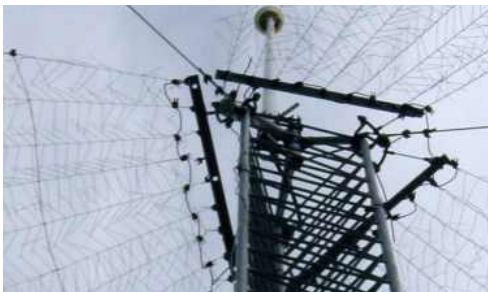
사다리형 어레이(Trapezoid Array) 산업용 또는 통신타워등에 적용되며 측방위에 방지에 효과적임.
