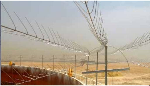
가장자리 어레이(Rim Array) Float Roof형의 유류 또는 가연성 물질 저장 탱크에 적용.
