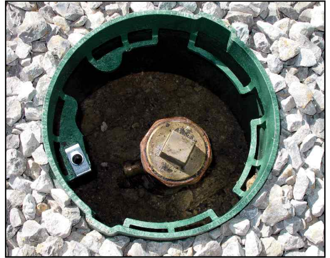
설치 후 접지 점검구
